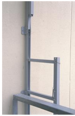
Kuva 3. Tikas aukaistuna jatkoksen kohdalta.
