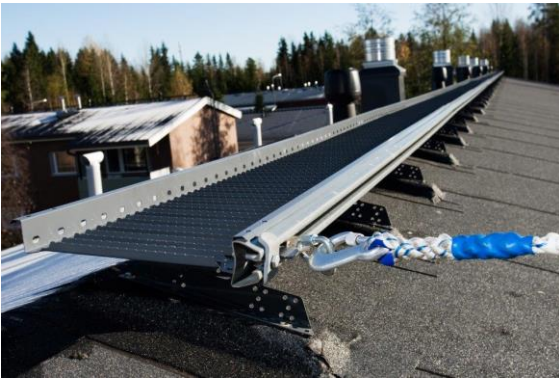
Kuva 1. Vaakakisko kattosillassa
