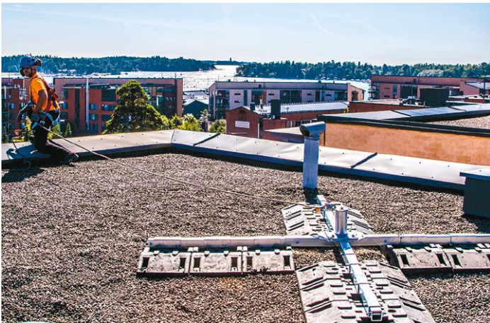
Kuva 1. Vastapainoankkuri, paino 374 kg
