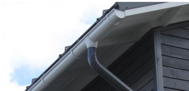
P13 kouru ulkopuolisella kannakkeella ja liukulähtö
