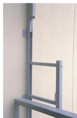
Kuva 3. Tikas aukaistuna jatkoksen kohdalla
