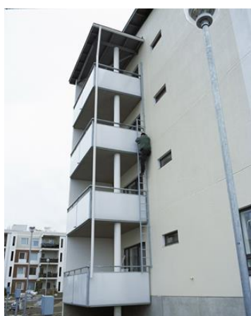
Kuva 5. Henkilö poistuu parvekkeelta
