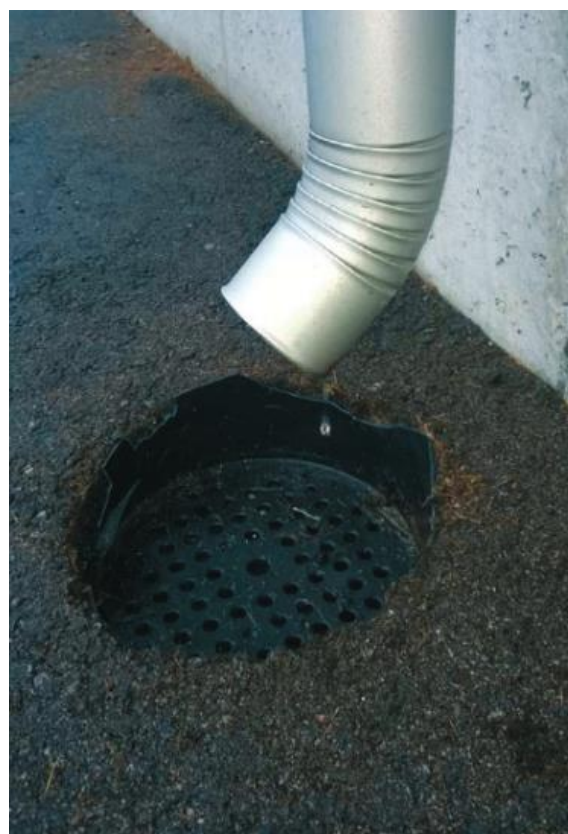
Kuva 2. Muovinen sadevesikaivo rikkoontuu helposti pihaa asfaltoidessa tai kolatessa.
