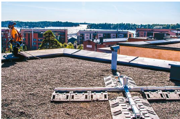
Kuva 1. Vastapainoankkuri, paino 374 kg
